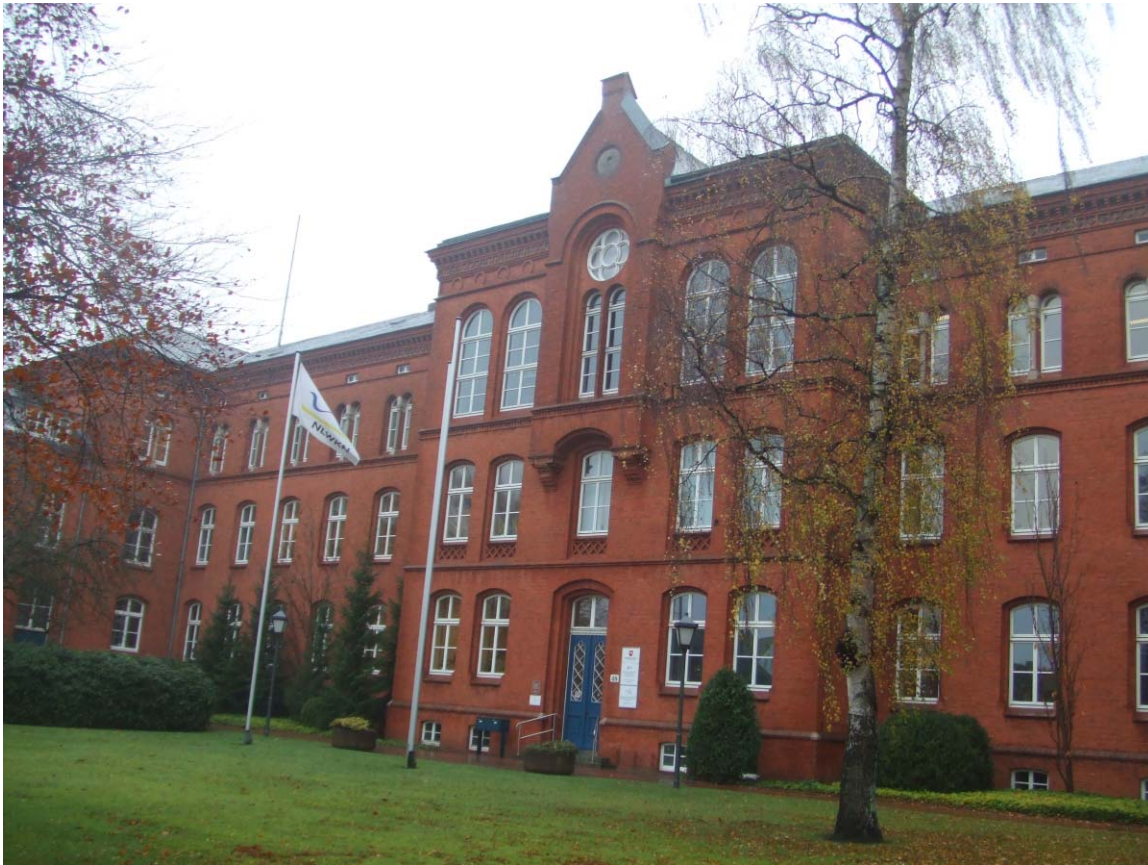
Foto: NLWKN Betriebsstelle Aurich - Oldersumer Str. 48 - 26603 Aurich
